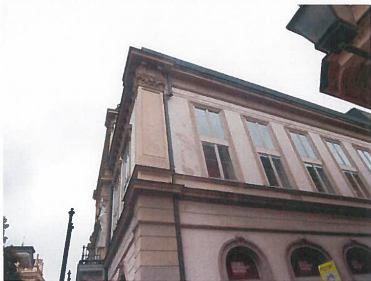
Slika 9: Lokalne poškodbe fasadnega ometa, luščenje opleska
