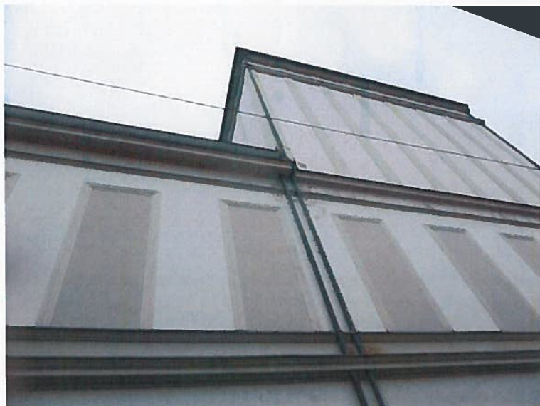
Slika 13: Lokalne poškodbe fasade v območju žlebov oziroma vertikalnih cevi, vidni sledovi zamakanja ob prebojih fasadnih vencev, vertikalne razpoke
