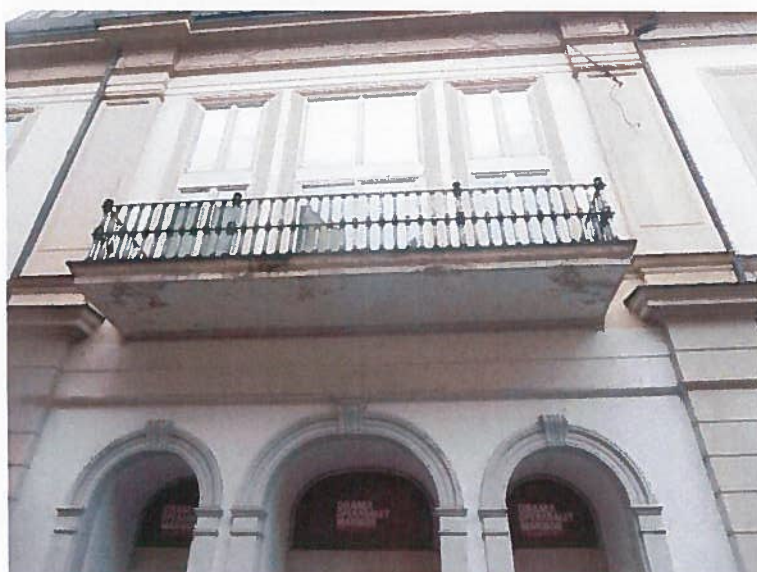
Slika 12: Poškodbe na balkonski plošči: razpadanje betona, sledovi zamakanja, luščenje opleska
