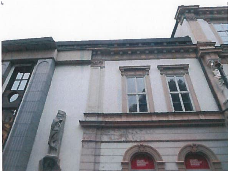
Slika 7: Lokalne poškodbe fasadnega ometa, luščenje opleska
